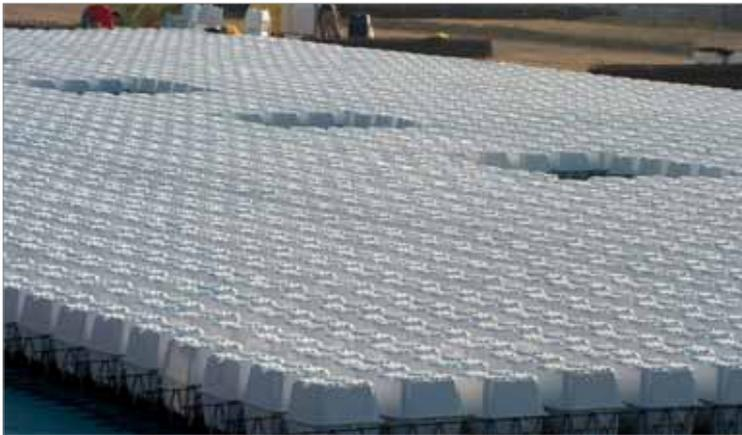
U-Boot Beton<sup>®</sup> используется для зданий сферы обслуживания (больницы, парковки, подземные структуры, коммерческие здания и т.д.), жилых помещений (в большей степени, средних и крупных размеров) и промышленных (основания под фундамент значительной толщины с меньшим количеством бетона, *см.рисунок*).
